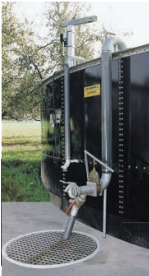
Tubo aspirante per silo per liquami
