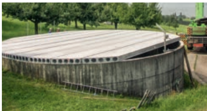
Copertura con elementi cavi in calcestruzzo precompresso
