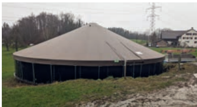
Tetto a doppia membrana per impianti di biogas
