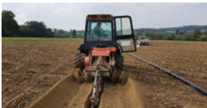
Realizzazione di tubazioni posate nel terreno, PE saldato o PVC con manicotto Compresa prova di tenuta
