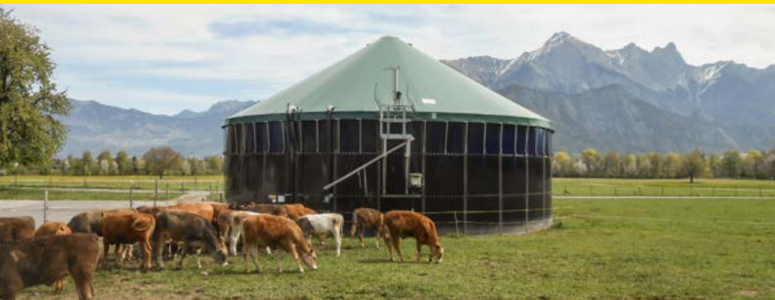
Coperture con telone
